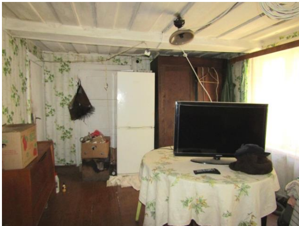
Põhikorrusel asuv tuba 3
