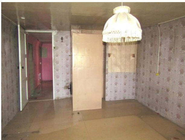
Katusekorrusel asuv tuba 2
