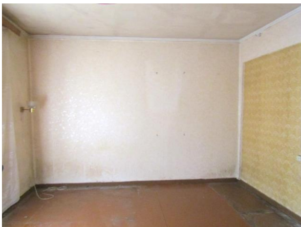
Põhikorrusel asuv tuba 2
