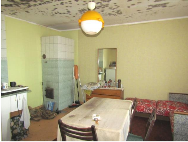
Põhikorrusel asuv tuba 1
