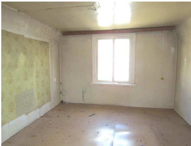
Katusekorrusel asuv tuba 1
