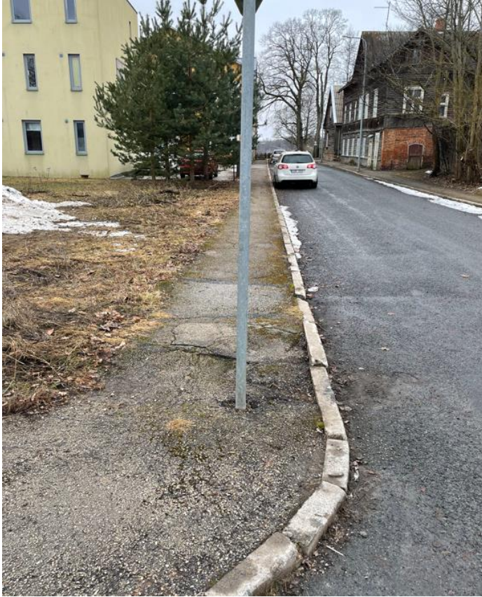
Foto 4 - Kõrge äärekivi, liiklusmärk keset kõnniteed, lagunenu kate
